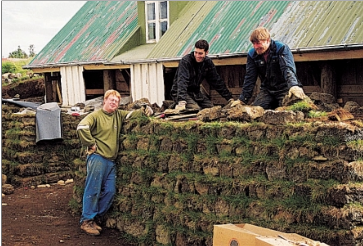
Mynd 19. Víglundur Kristjánsson (lengst til hægri), hefur að mestu séð um hleðsluvinnuna á Keldum. Hér er hann að hlaða upp vesturvegg baðstofunnar, ásamt aðstoðarmanni sínum, Birni Hrannari Björnssyni. Hjá þeim stendur Oddur Bjarni Þorkelsson. Ljós. Þór Hjaltalín.
