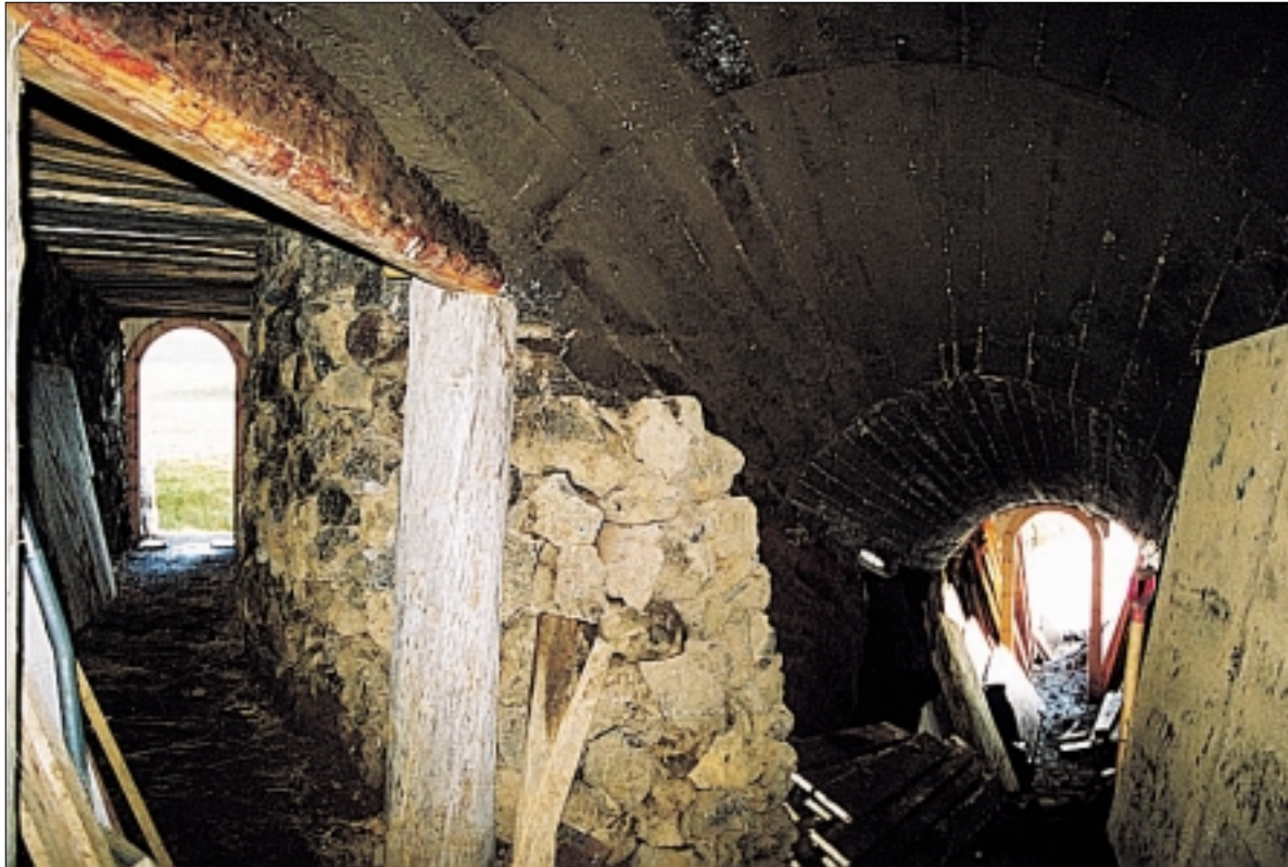
Mynd 12. Horft í suðurátt út úr göngunum í október 1998. Til vinstri eru Matthíasargöngin, hlaðin úr grjóti. Hægra megin eru hin moldarsteyptu göng. Eftir er að snyrta hvelfinguna til þess að afmá ummerki mótatimburs. Ljós. Þór Hjaltalín.
