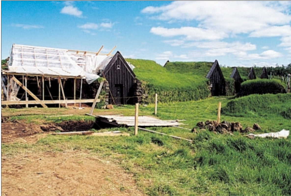
Mynd 4. Keldnabærinn; horft til austurs sumarið 1998. Framkvæmdir standa yfir við skálann og er búið að taka niður suður-vegg hans. Framan við hann er byrjað að grafa snið og þess freistað að finna framhald hinna fornu jarðganga. Austan við bæjardyraþil skálans er búið. Þar taka við fjórir stafnar og er sá fremsti Stóraskemma, þá Litlaskemma, smiðja og hjallur. Ljós. Þór Hjaltalín.
