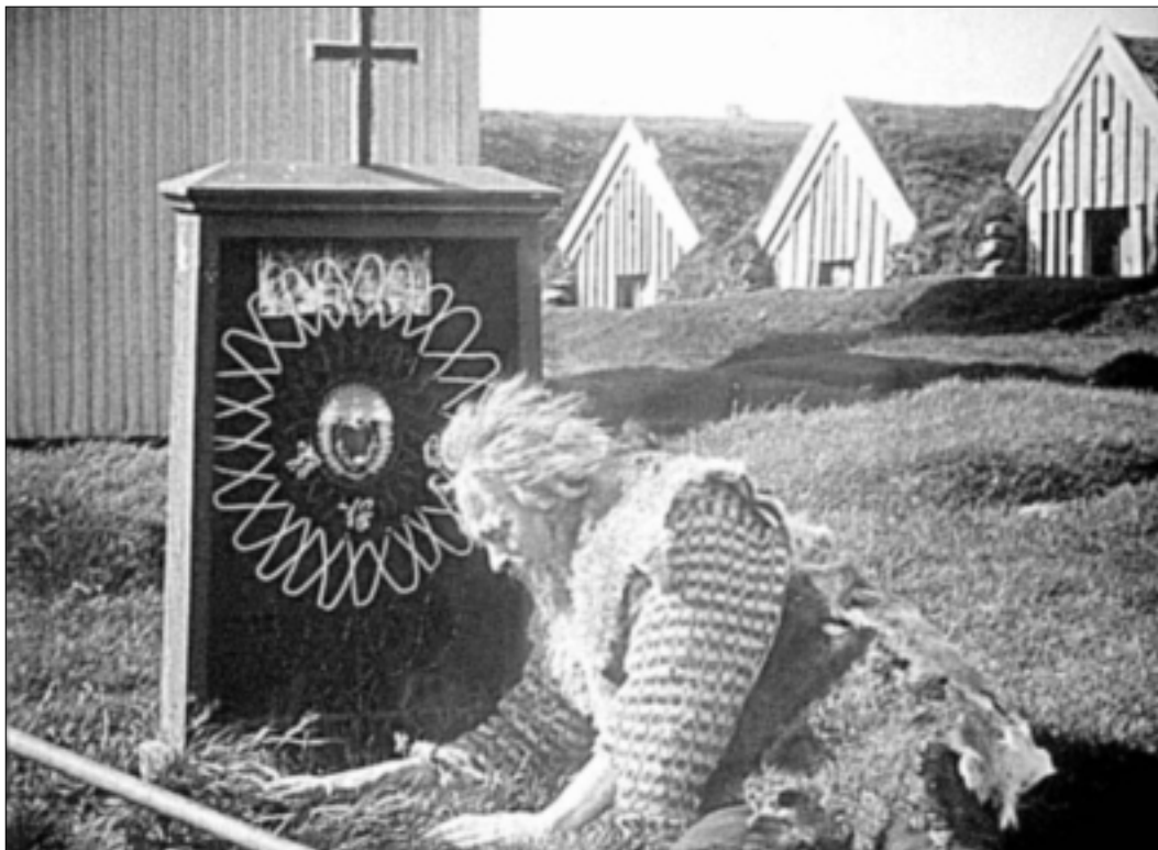
Mynd 15. Við endurgerð stafnpilja á hjalli var m.a. stuðst við kvikmyndina Sögu Borgarættarinnar , sem að hluta var tekin upp á Keldum árið 1919. Rimlapil hjallsins blasir við lengst til hægri. Myndin er tekin eftir filmu frá Kvikmyndasafni Íslands.
