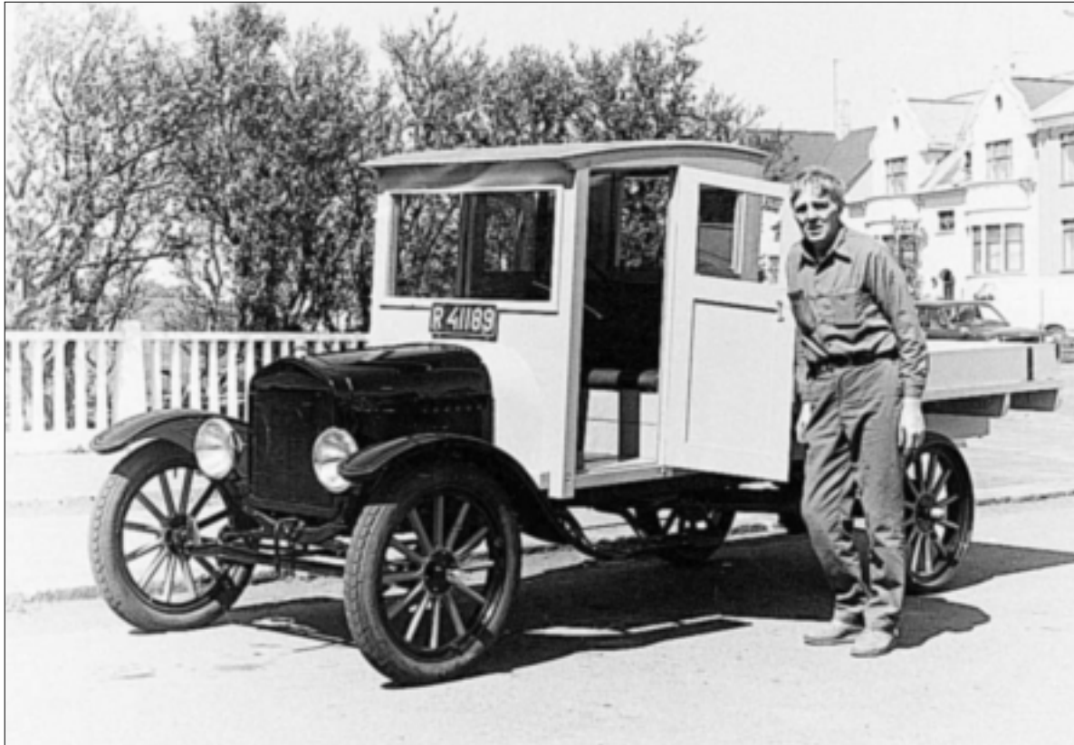
Mynd 21. Mismunandi hefð hefur skapast við viðgerðir gripa, eftir því hvaða muni um er að ræða. Gamli Vífilstaða Fordinn frá 1917 fékk Þjóðminjasafnið í sína vörslu árið 1971. Þá var hann að segja má ónýtt ryðhræ, hvorki sýnigarhæfur eða neinum til gamans. Á árunum 1977-78 gerði Pétur G. Jónsson, sem hér sést á myndinni, bílinn upp og smíðaði í hann varahluti. Myndin er tekin árið 1978 og bílinn er orðinn eins og nýr. Þjms. 7120.
