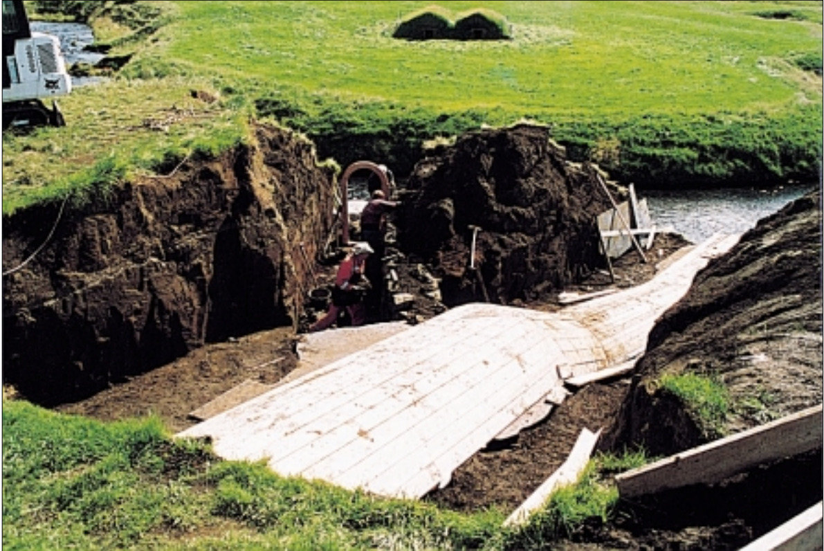
Mynd 11. Þann 13. ágúst var slegið upp mótum fyrir moldarsteypuhvelfinguna sunnan við þró. Grafnir höfðu verið eins metra stallar beggja vegna við gangaveggina þar sem hvelfingin skyldi hvíla. Haraldur, Oddur Bjarni og Bergsteinn eru önnur kafnir við að hlaða upp Matthíasargöngin. Fjær sést í Lambhúsin sunnan við læk. Ljós. Þór Hjaltalín.
