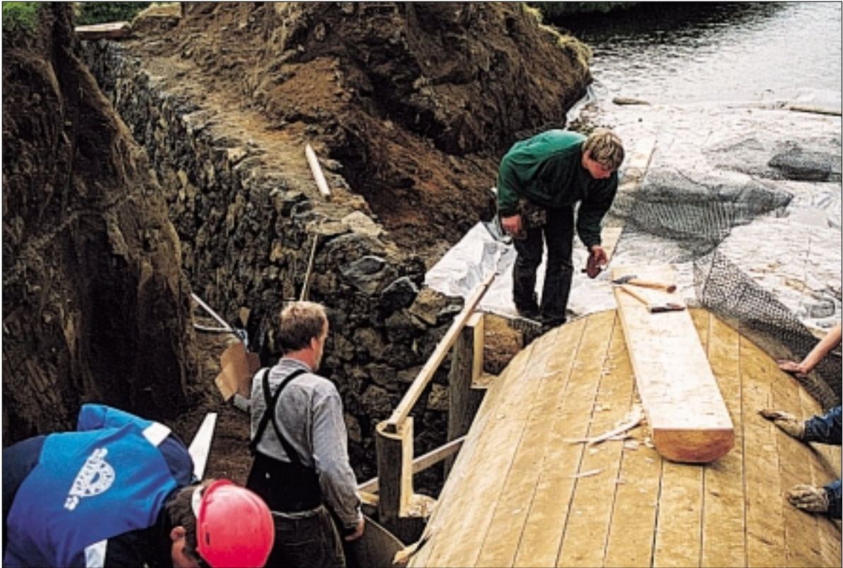
Mynd 18. Þórhallur Hólmgeirsson (fyrir miðri mynd) hefur séð um mest alla smíðavinnu á Keldum. Hér er hann að koma fyrir bita miklum við enda Matthíasarganga, þar sem þau ganga inn í hin upprunalegu göng. Ljósmynd. Þór Hjaltalín.
