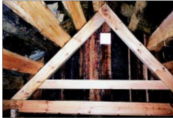
Mynd 23. Horft norður eftir hjallinum. Árið 1892 var hjallinum lokað, þ.e. sett listabil á norðurstafrinn og smíðaðir hlerar fyrir grindurnar að framan ásamt því að hurð var sett fyrir dyraopið. Á norðurgafflinn var sett op á þilið og hleri fyrir með krók. Hér hefur verið tekið úr fyrir opinu á miðjuborðinu, en þessu opi má loka með hlera. Gunnar Bjarnason smíðaði bæði lamir og krók eftir fyrirmynd frá Keldum. Ljós. Þórhallur Hólmgeirsson.
