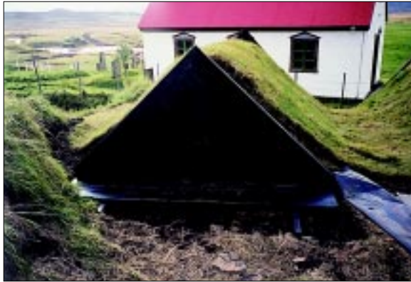
Mynd 22. Norðurstafrn hjallsins. Vatnsvarnardúkurinn var látinn liggja á skábretti til þess að beina vætunni frá húsinu. Við samskeyti þils og brettis var settur skáhallandi listi, þar sem dúkurinn var negldur. Ljós. Þórhallur Hólmgeirsson.
