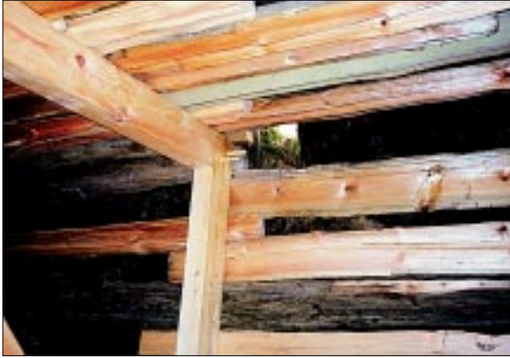
Mynd 16. Loftop var gert á þekju smiðjunnar, beint yfir smiðnum, sunnan megin við aflinn. Ljós. Þórhallur Hólmgeirsson.
