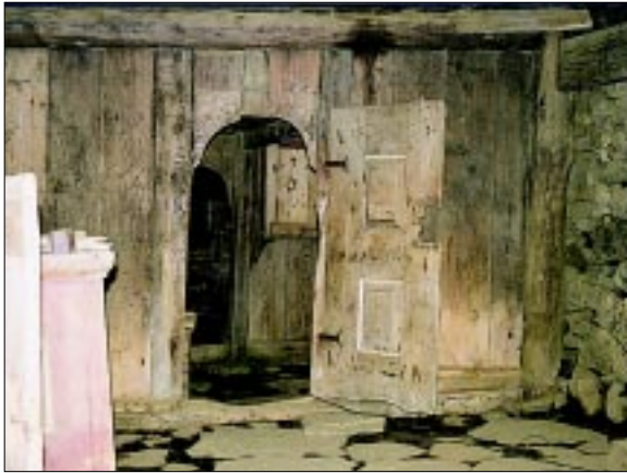
Mynd 28. Skálahurðin komin á sinn stað eftir viðgerð. Spjaldahurð þessi kom úr kirkjunni á Hlíðarenda árið 1802. Ljós. Þór Hjaltalín.
