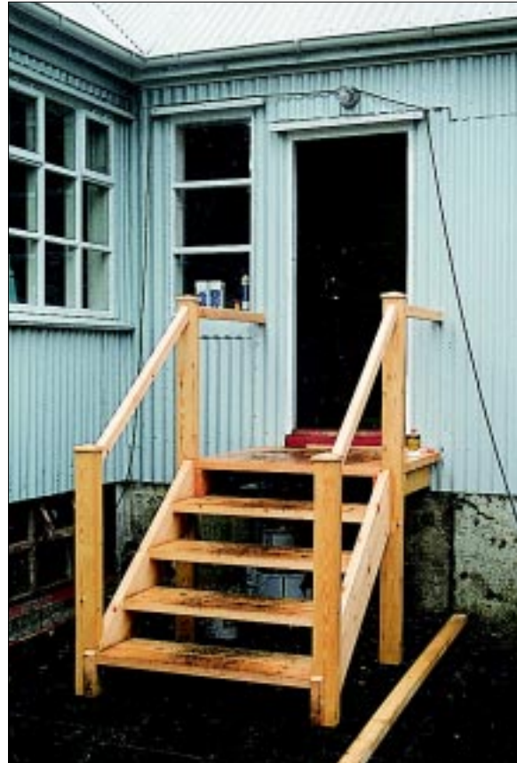
Mynd 35. Úttröppur timbri voru smíðaðar á verkstæði Gunnars Bjarnasonar í stað steintrappanna áður. Ljós. Þór Hjaltalín.
