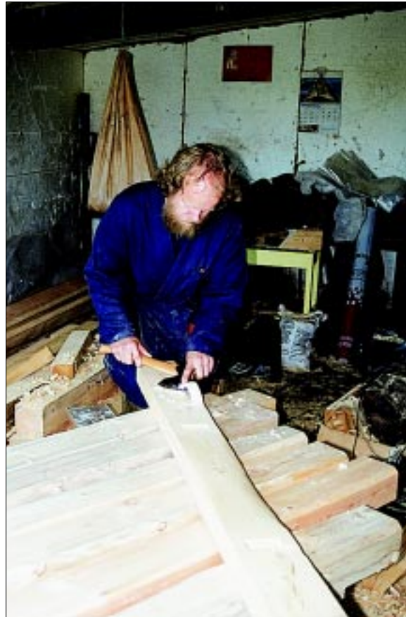
Mynd 11. Þórhallur leggur síðustu hönd á smiðjuviðina fyrir uppslátt þann 19. ágúst 1997. Áferð viðarins í smiðjunni var hafður nokkuð grófari en á hjallinum og var reynt að líkja eftir áferð skálaviðanna. Hér beitir Þórhallur öxinni. Ljós. Þór Hjaltalín.
