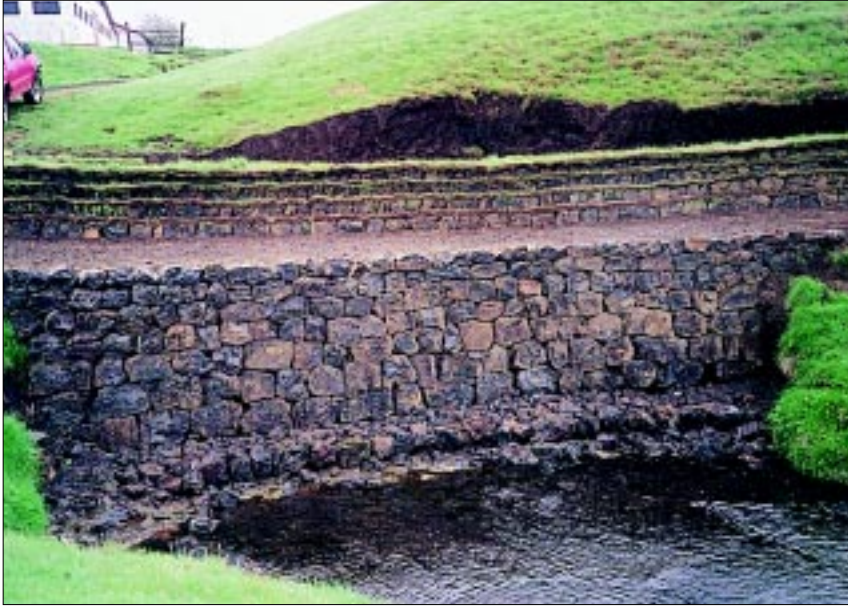
Mynd 5. ... að loknu verki. Veggurinn full hlaðinn ásamt norðurgarðinum, sem hafður var með fjórum grjótlögum og tvöföldum streng á milli. Ljós. Ari Jóhannesson.
