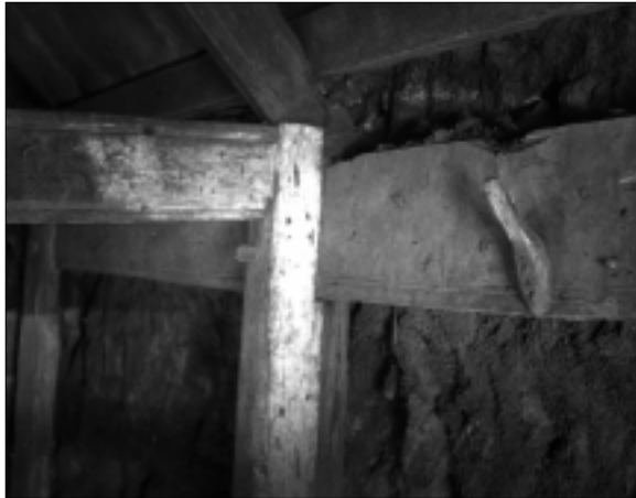
Mynd 10. Samsetningin á grind Gunnsteinsstaðakirkju í Langadal var með sama hætti og sjá má á Keldum og ber hún ýmis einkenni stafverks. Gunnsteinsstaðakirkju taldi Guðbrandur Jónsson vera miðaldasmíð og var hún öll sett saman með trénöglum. Í viðnum eru miðaldaskreytistrik sem minna á Keldur. Ljós. Matthias Þórðarson (Þjms. 1923:17)
