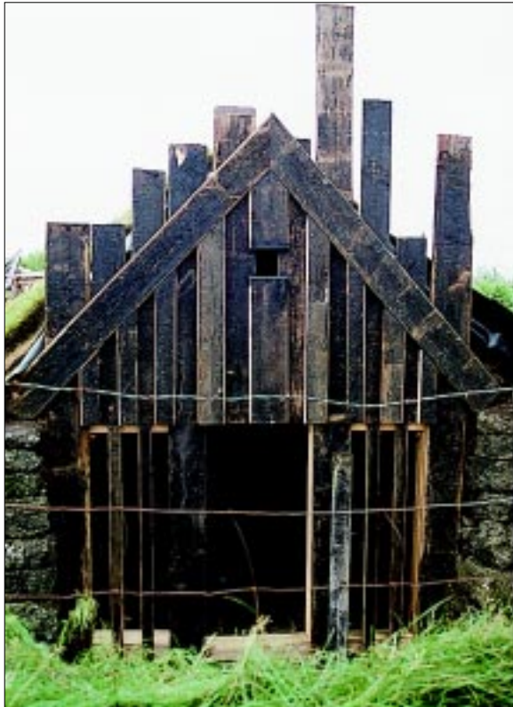
Mynd 18. Hjallurinn kominn með rimla líkt og áður var. Þessu var lokað með hlerum. Ljós. Þór Hjaltalín.
