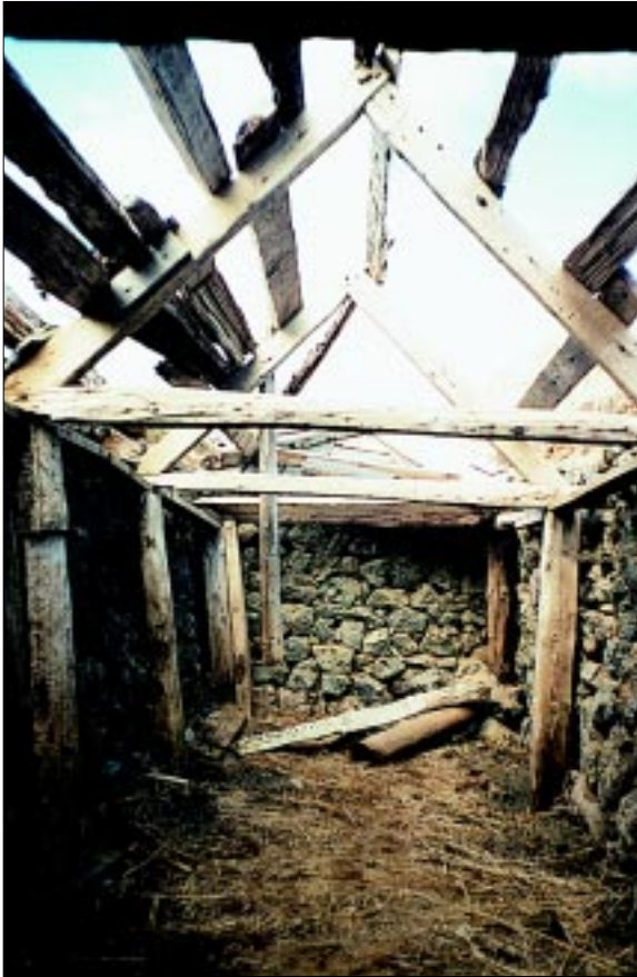
Mynd 8. Séð inn eftir hjallinum þann 13. maí 1997. Grindinni í hjallinum og smiðjunni hafði verið "tjaslað saman". Því var nauðsynlegt að sækja fyrirmyndina í skemmurnar. Ljós. Þórhallur Hólmgeirsson.
