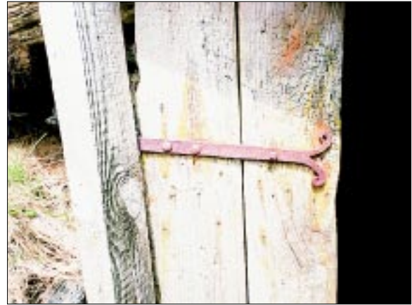
Mynd 29. Fyrirmyndir að lömum má víða finna á Keldum. Hér sést löm með hrútshornslagi á útihurð vesturhesthúss, en hún er með sama sniði og búhurðarlömin. Ljós. Þórhallur Hólmgeirsson.
