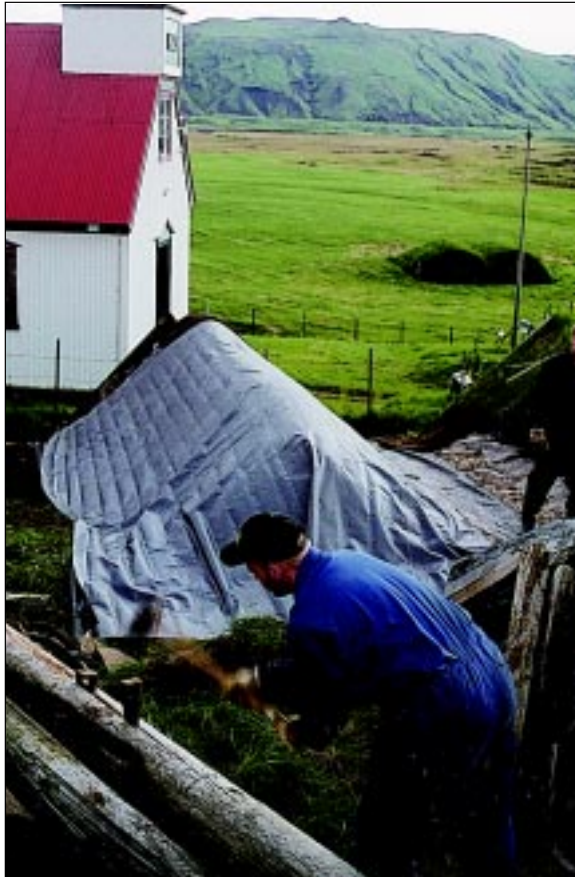
Mynd 14. Unnpór klýfur rekaviðinn með fleyg. Á bakvið sést í Víglund leggja vatnsvarnardúk á smiðjuna. Ljós. Þór Hjaltalín.
