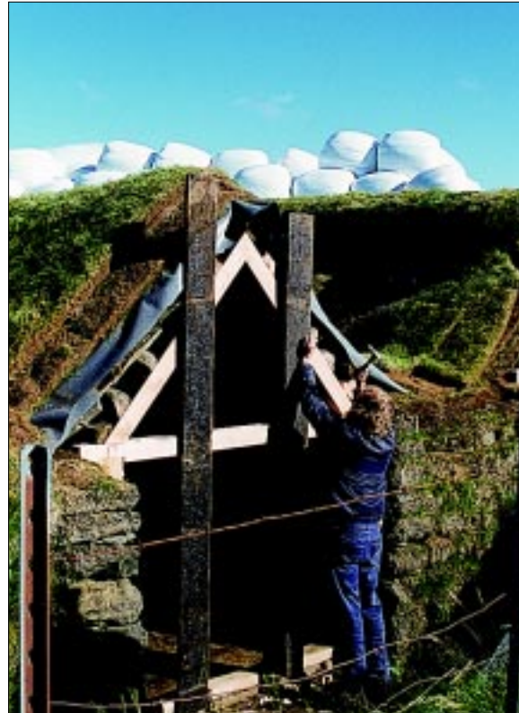
Mynd 19. Þórhallur hefst handa við stafnpílsmíðina. Hér neglir hann fyrstu þiljurnar á smíðjuna með nöglum úr eldsmiðju Gunnars Bjarnasonar. Myndin er tekin í byrjun september, en verkinu lauk um 1. október. Ljós. Þór Hjaltalín.
