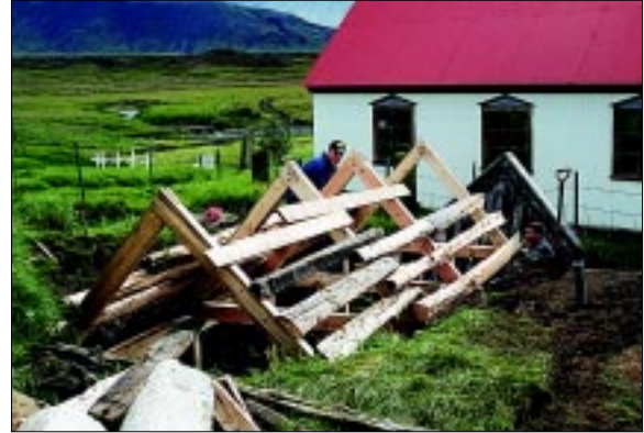
Mynd 13. Unnpór og Víglundur negla rafta á sperru hjallsins. Nauðsynlegt reyndist að endurnýja þá nánast alla. Ljós. Þór Hjaltalín.
