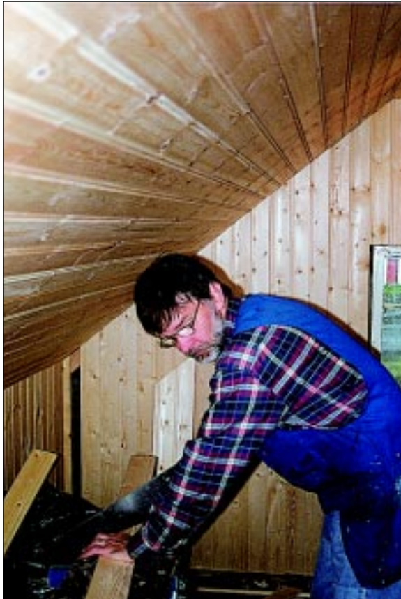
Mynd 34. Leifur Ebenezerason sagar niður panel í risið. Gunnar og Leifur luku við allan frágang í ágústlok. Ljós. Þór Hjaltalín.
