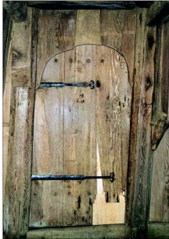
Mynd 27. Nýuppgerð hurðin komin á sinn stað á Keldum. Nýjar lamir voru smíðaðar, settir nýjir trénaclar þar sem þá vantaði og skeytt við brotna borðið. Engin tilraun er gerð til þess að "fela" viðgerðirnar. Ljós. Þór Hjaltalín.
