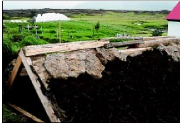
Mynd 15. Molda varð vel að hellunum og var það látið duga sem stuðningur við þær. Ljós. Þór Hjaltalín.
